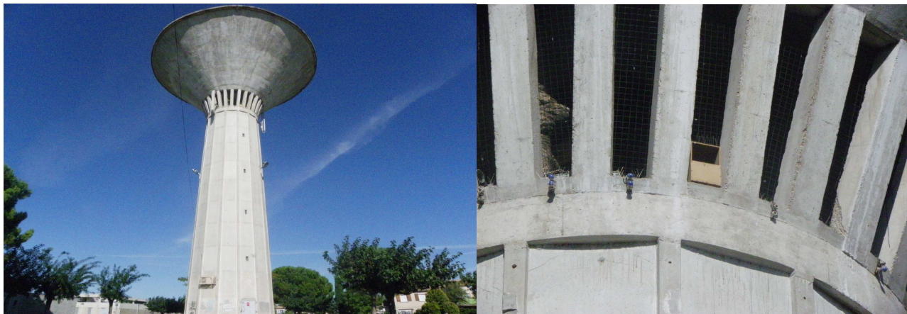
Nichoir à Faucon crécerelle installé en 2011 dans le château d'eau de Marguerittes dans le Gard
