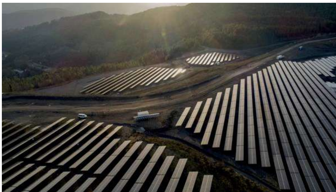
Parc photovoltaïque à La Grand-Combe – Urbasolar
